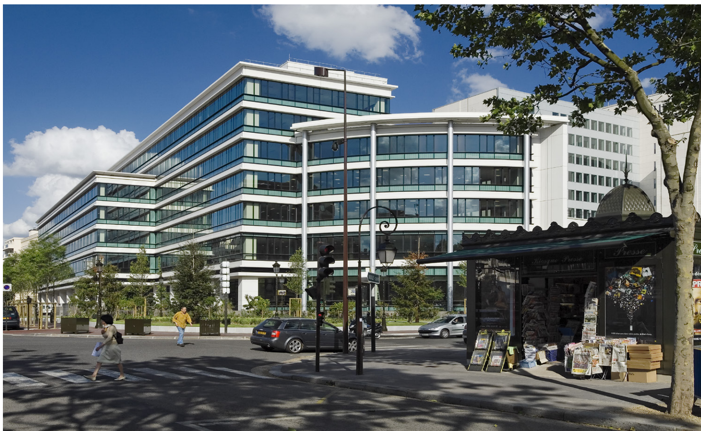
L'immeuble Libertis situé à Levallois-Perret (92) © Lobjoy-Bouvier-Boisseau
